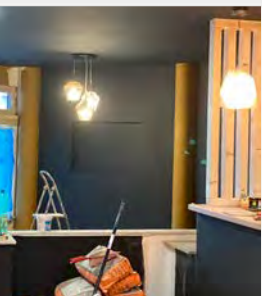
kurz vor Umbauabschluss
