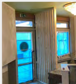
kurz vor Umbauabschluss
